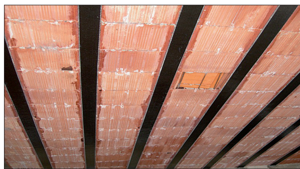
Solaio in ferro e tavelloni.
