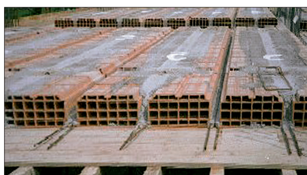
Solaio in laterocemento gettato in opera.
